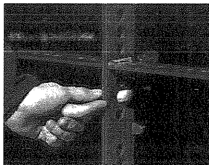
Łącznik typu Clip i sposób jego zakładania
